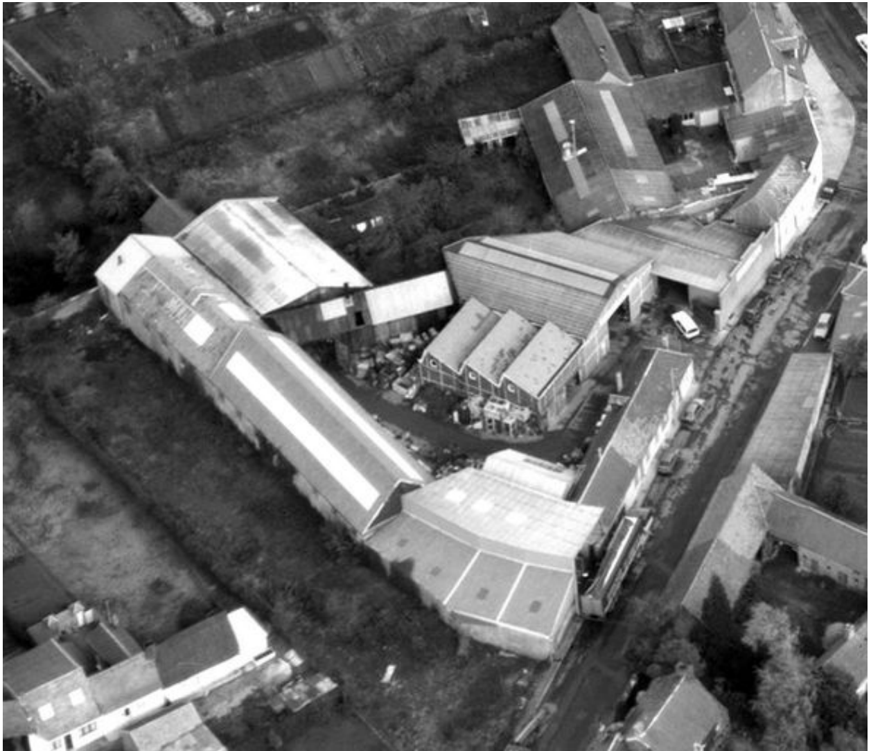
Vue aérienne, flanc sud-ouest.
