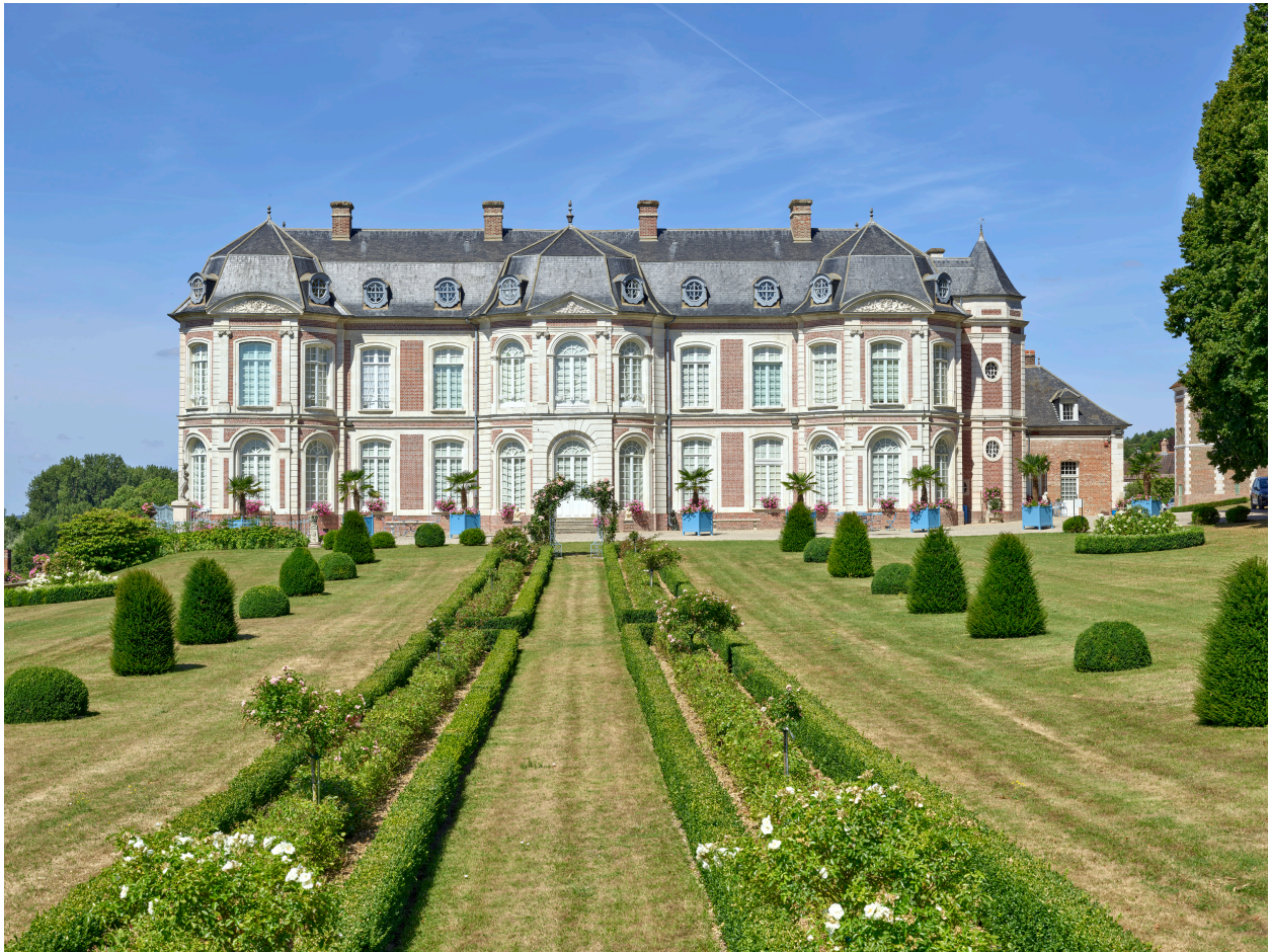
Façade sur jardin, vue d'ensemble.
