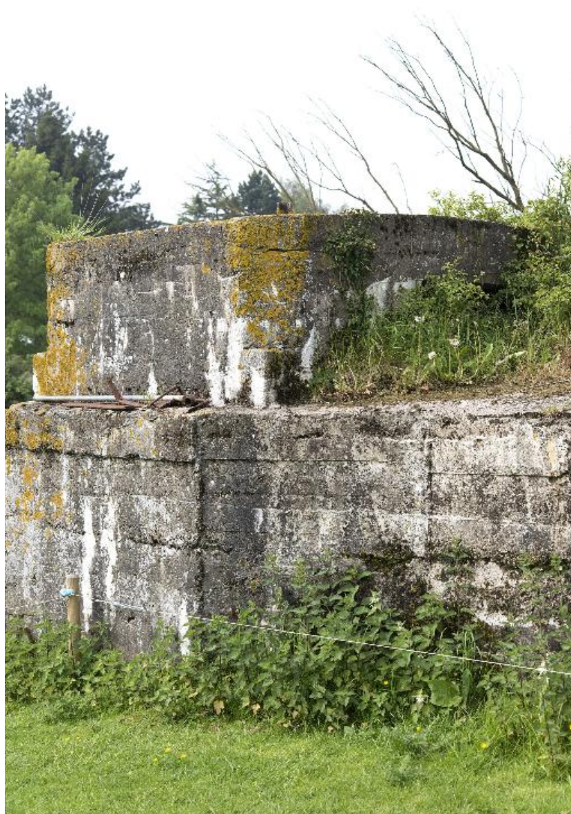
Détail du poste d'observation vers le sud-ouest
