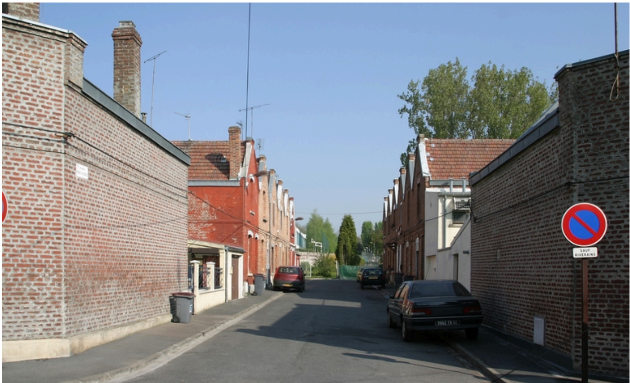
Logements ouvriers construits en 1922 dans l'impasse Pierre de Corbie.
