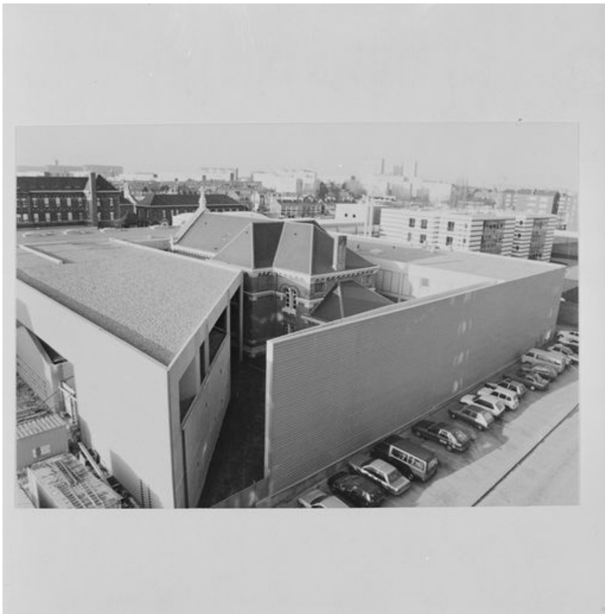
Vue aérienne de la chapelle, après les travaux de réaménagement.
