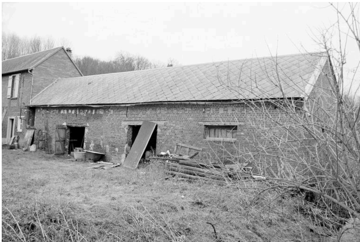
Ferme de la sucrerie : étable.
