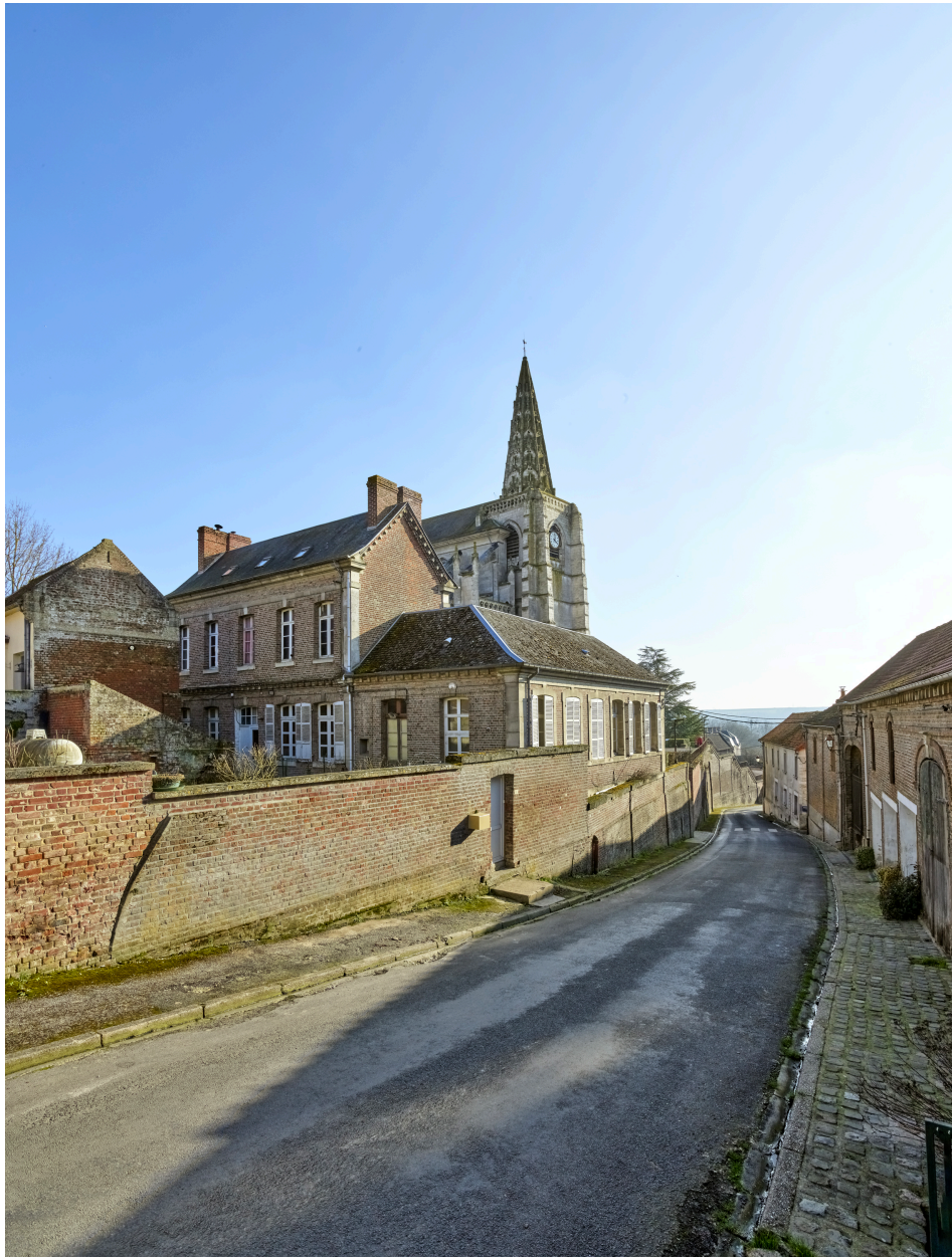
Vue de l'ancienne école des filles, depuis le nord.
