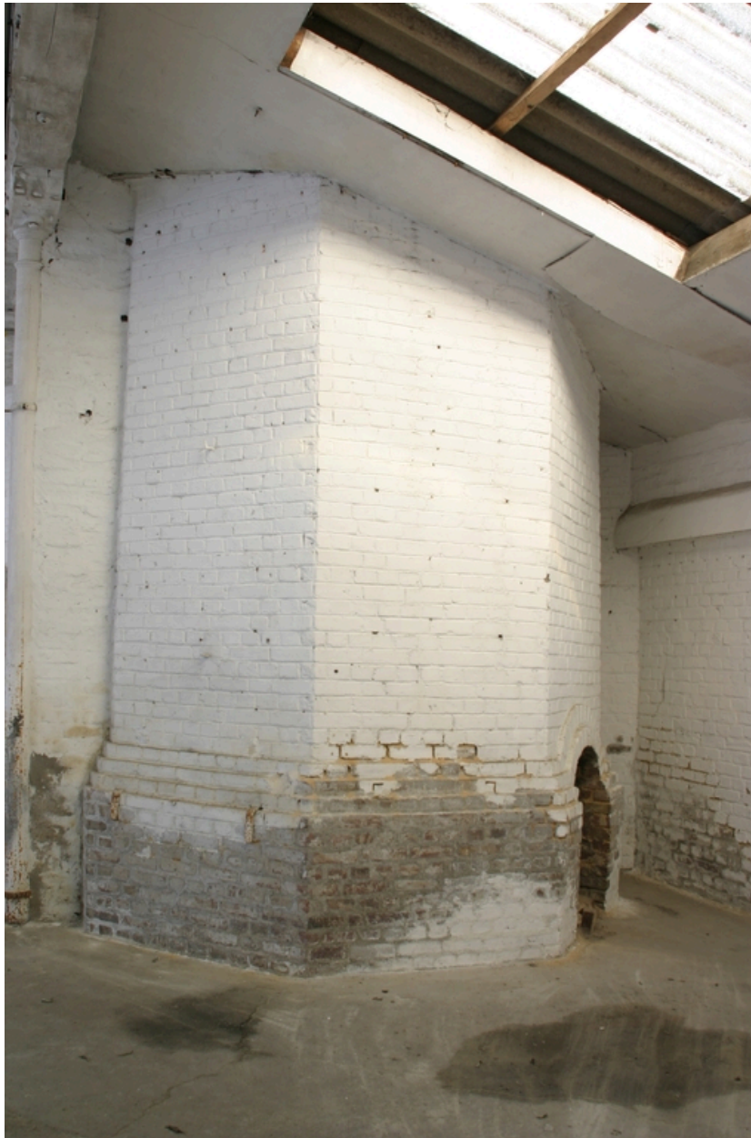
Base de la cheminée d'usine.
