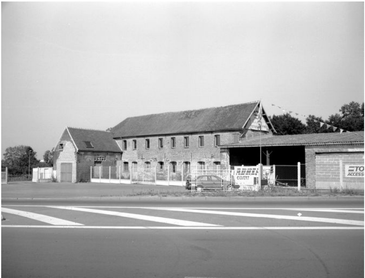
Vue générale de l'usine, côté Route de Paris.
