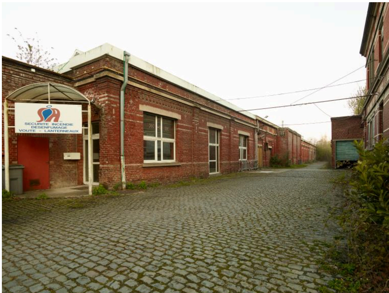
Magasin au toiles. Vue prise vers l'ouest.
