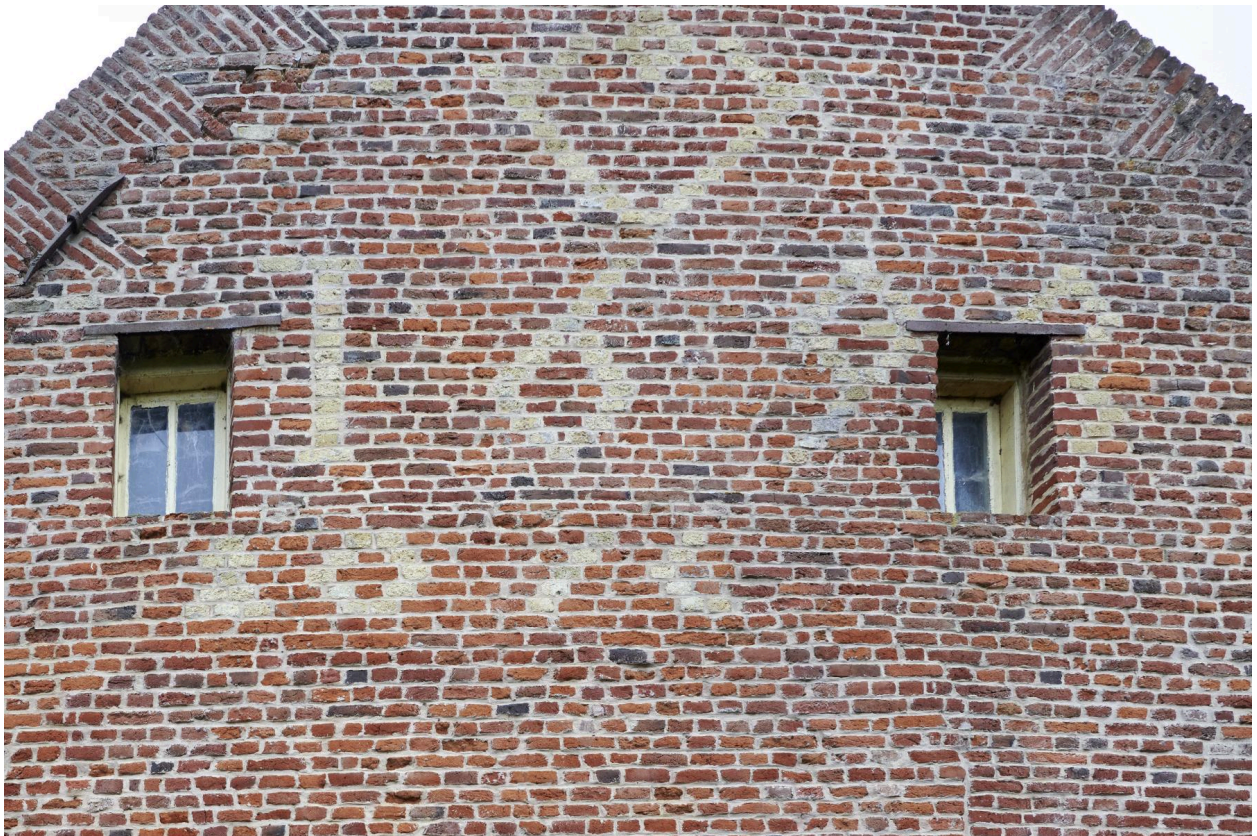
Détail du pignon est.
