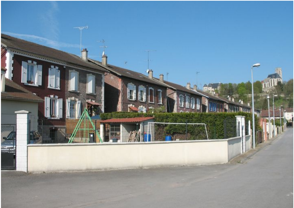
Une barre de logements ouvriers de la cité Louis Blanc.
