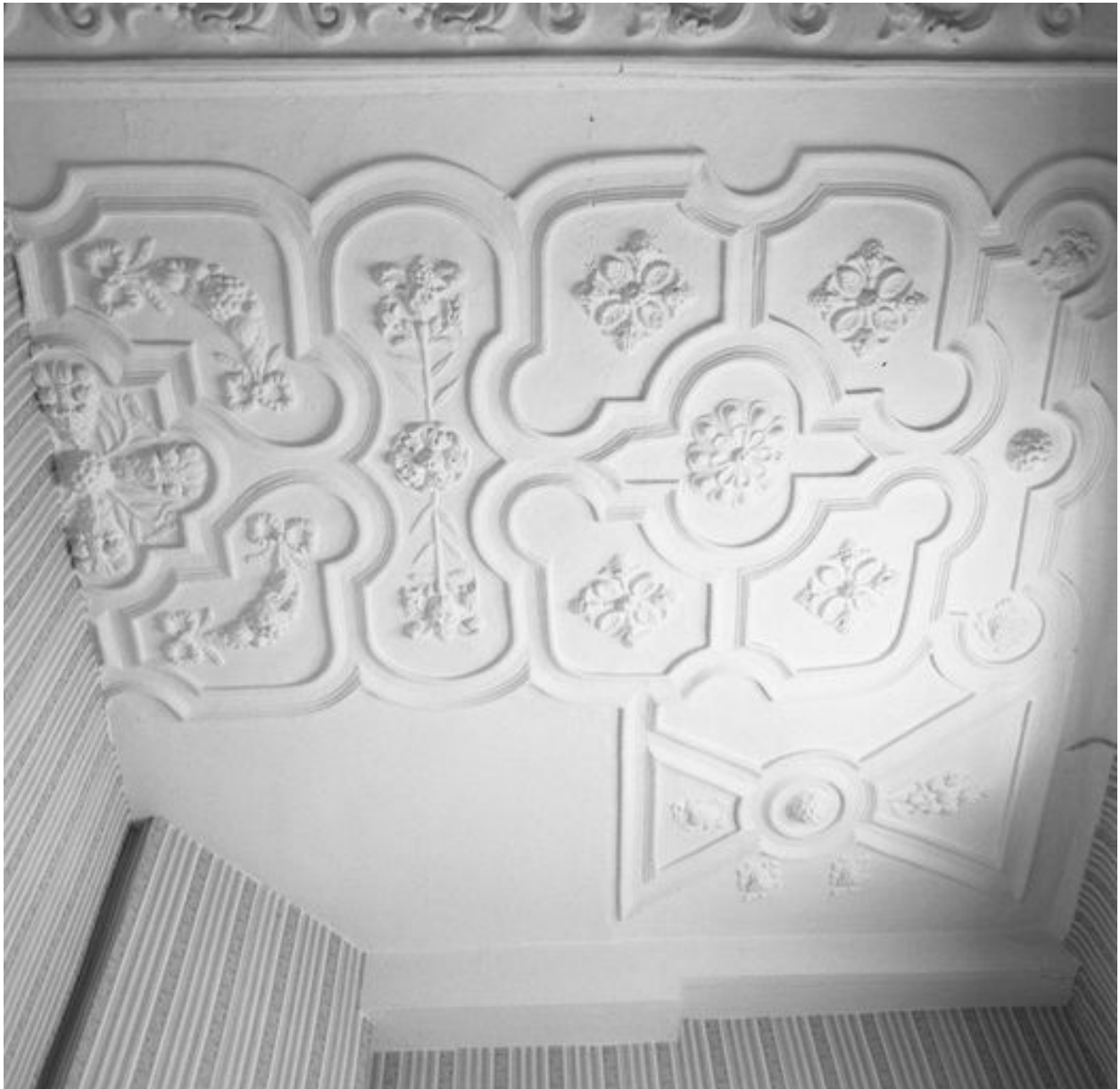
Vue partielle du plafond coupé par le cloisonnement en logements (ici, n° 35 rue de la Cavalerie).
