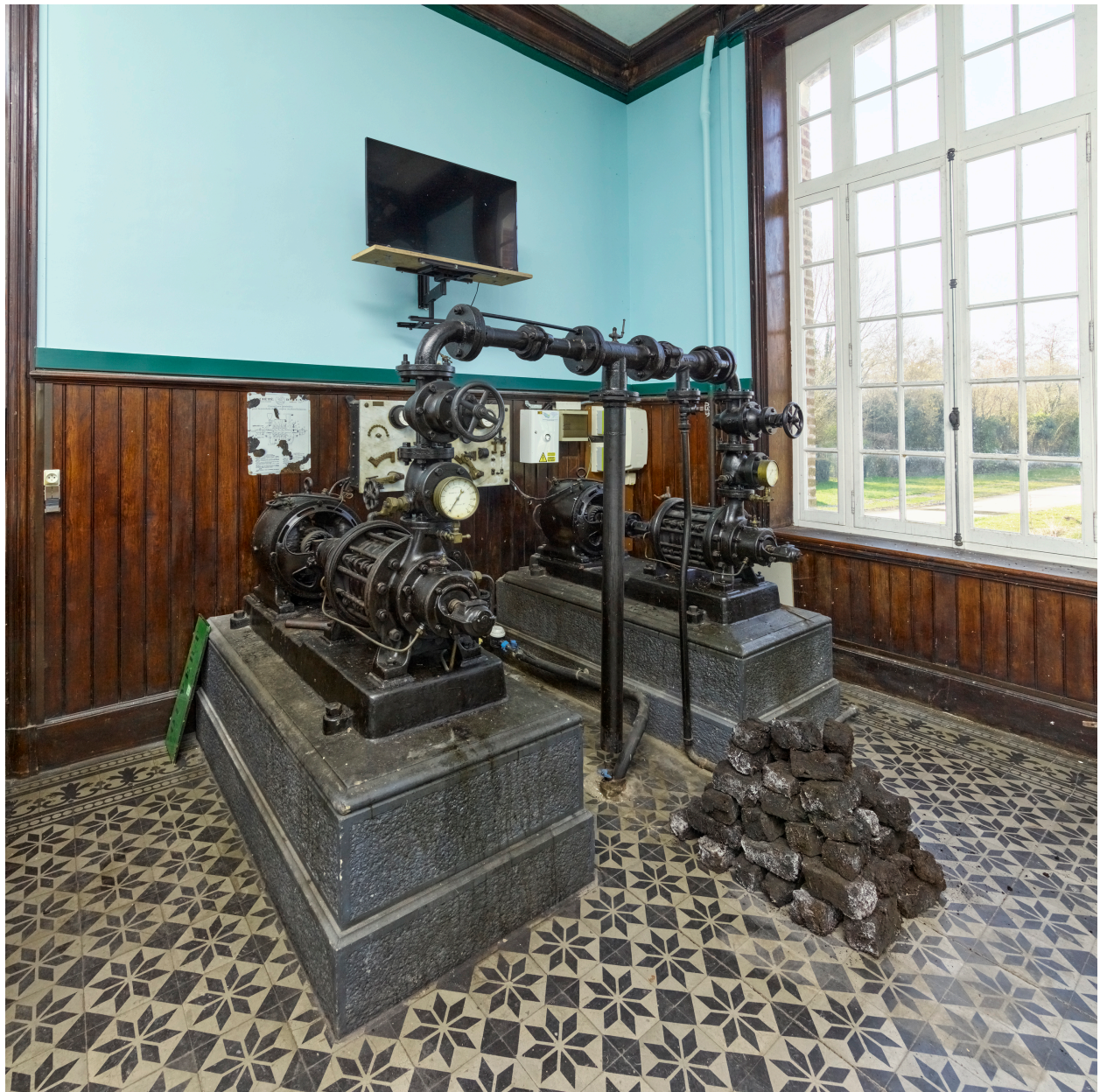
Intérieur, pompe à eau.
