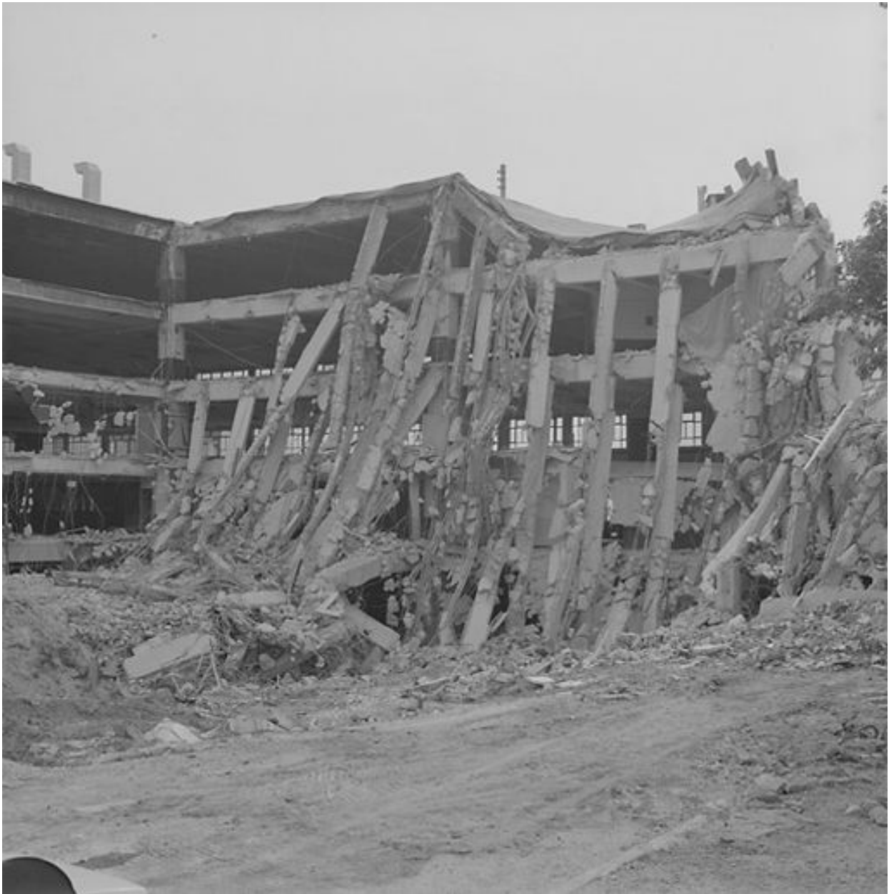
Vue d'ensemble du garage en cours de démolition, le 26 avril 1999.
