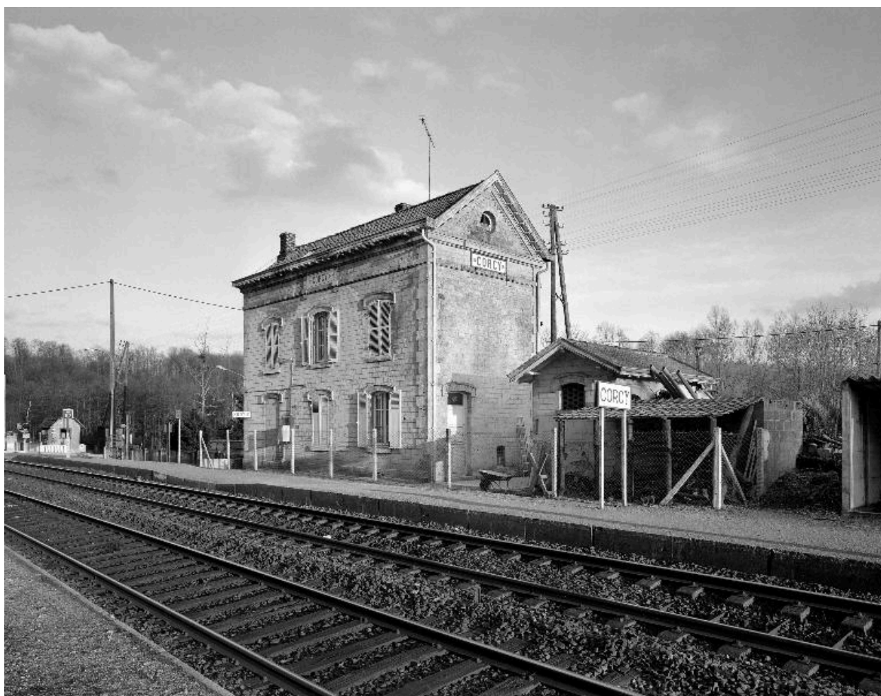
Vue générale nord-ouest de la halte, depuis la voie ferrée.
