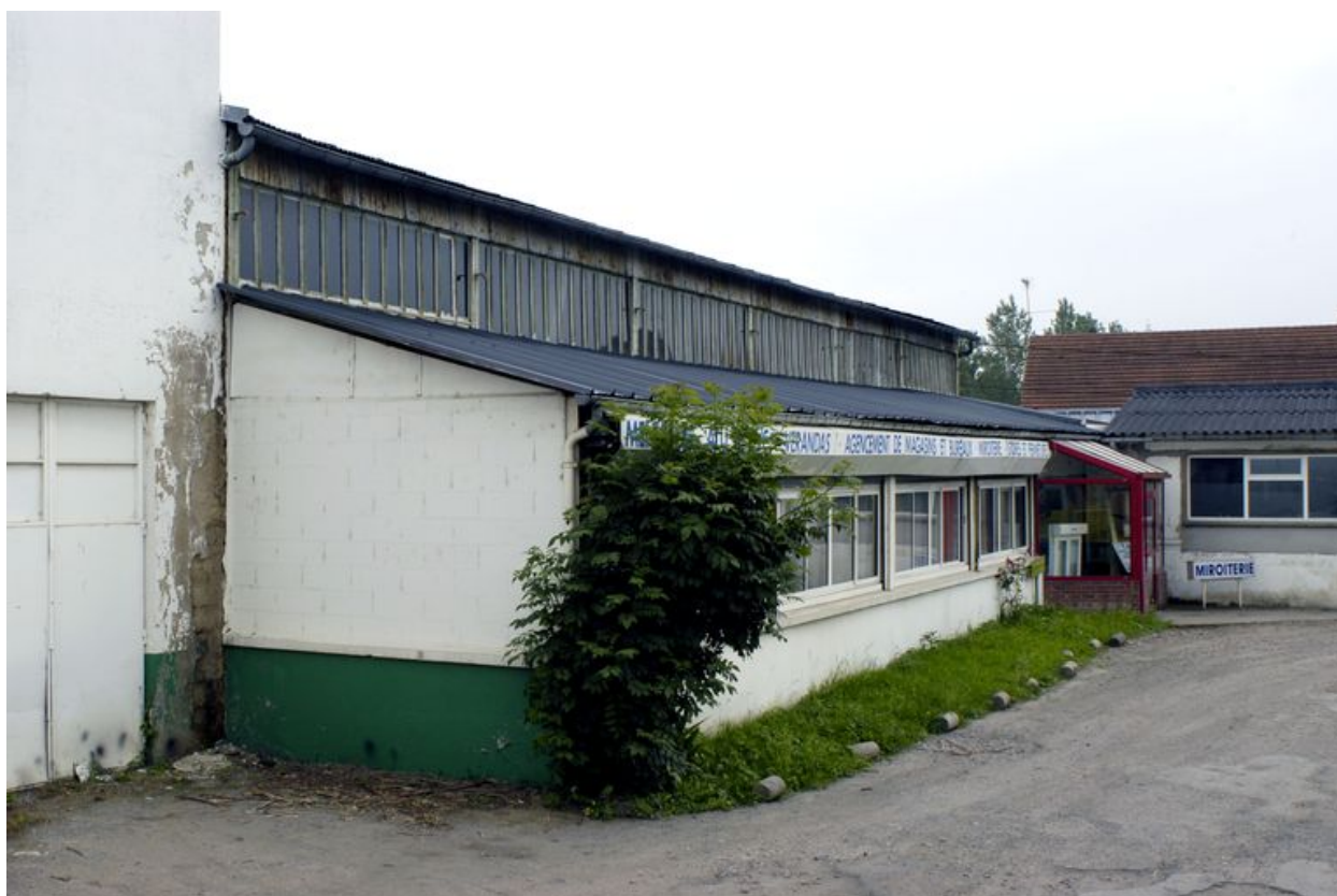
Les magasins entrepôts industriels, façade sur cour.
