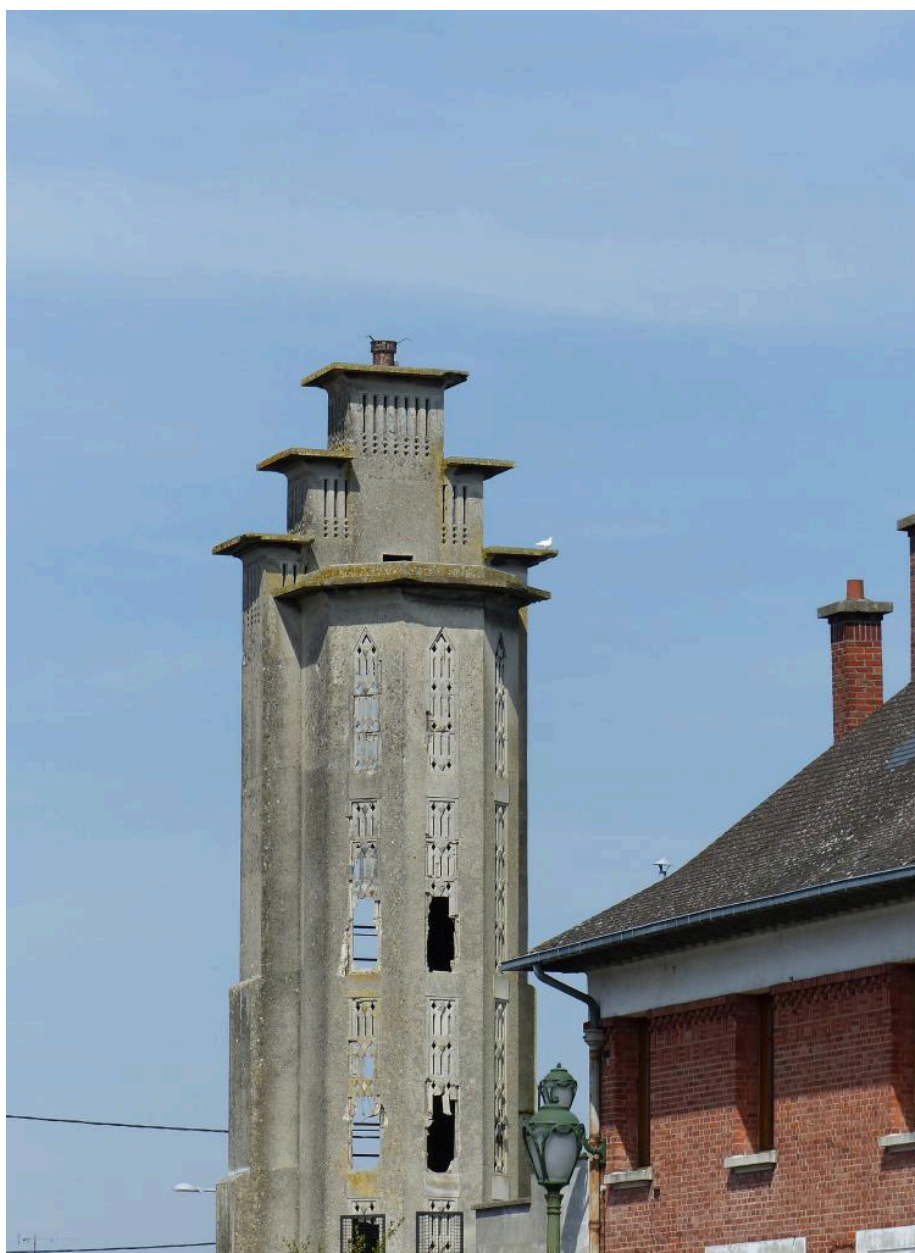
Vue de la partie supérieure de la tour et du réseau ajouré.
