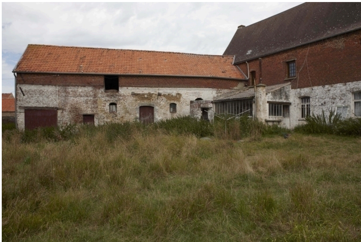
Vue de l'élévation sur cour des étables-fenil situées au nord-ouest.
