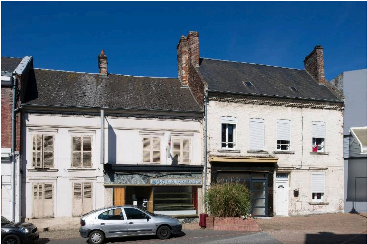
Maisons, rue de Noyon. A gauche, ancienne boulangerie parisienne, début du 19e siècle.
