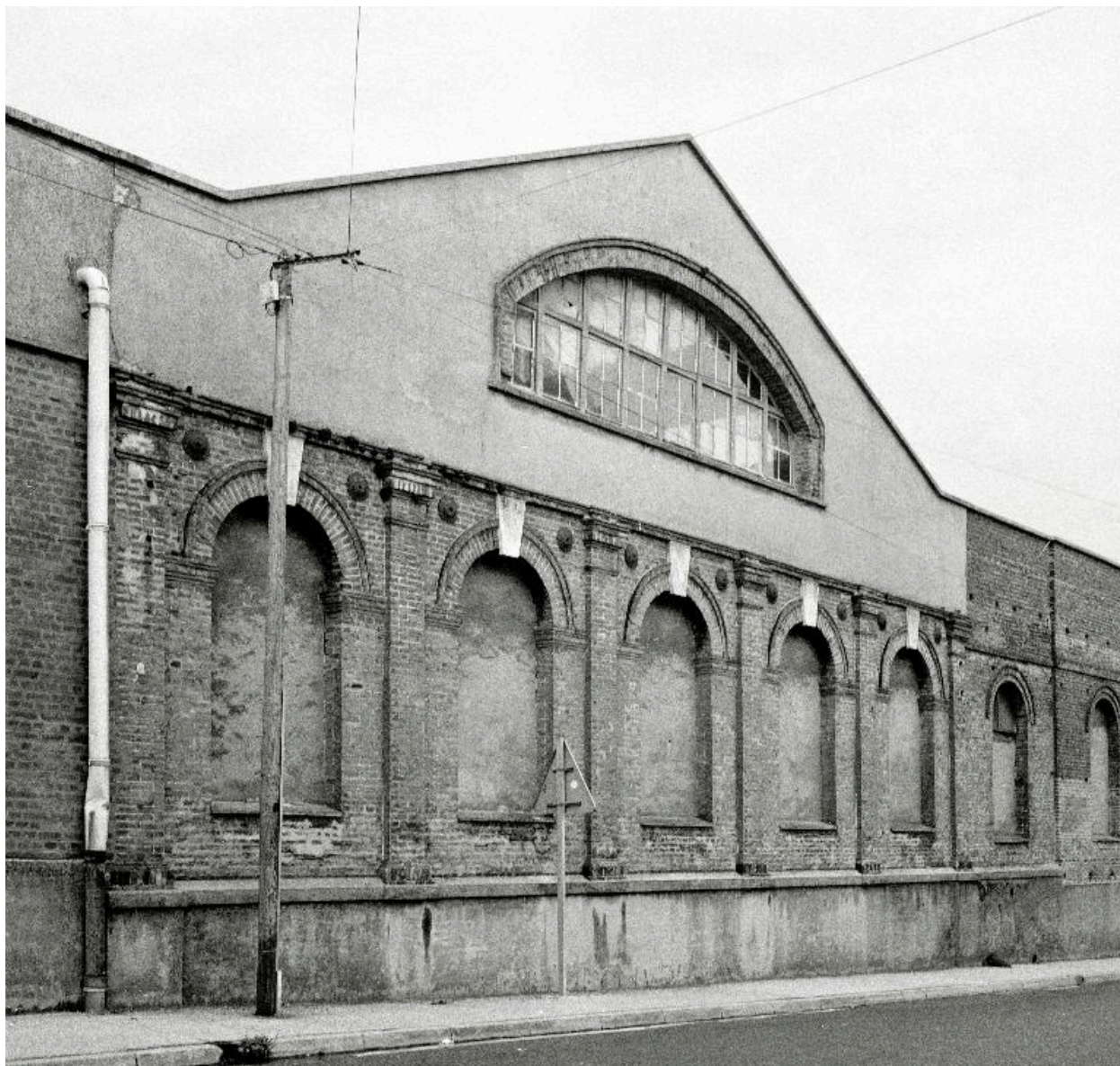
Les ateliers de fabrication depuis la rue du Chevalier de la Barre, en 1990.
