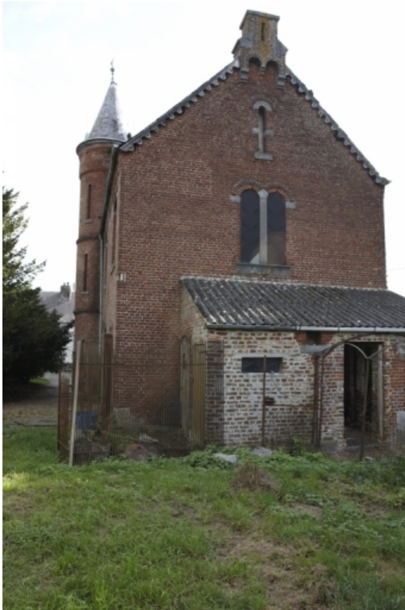
Vue du pignon des écuries.
