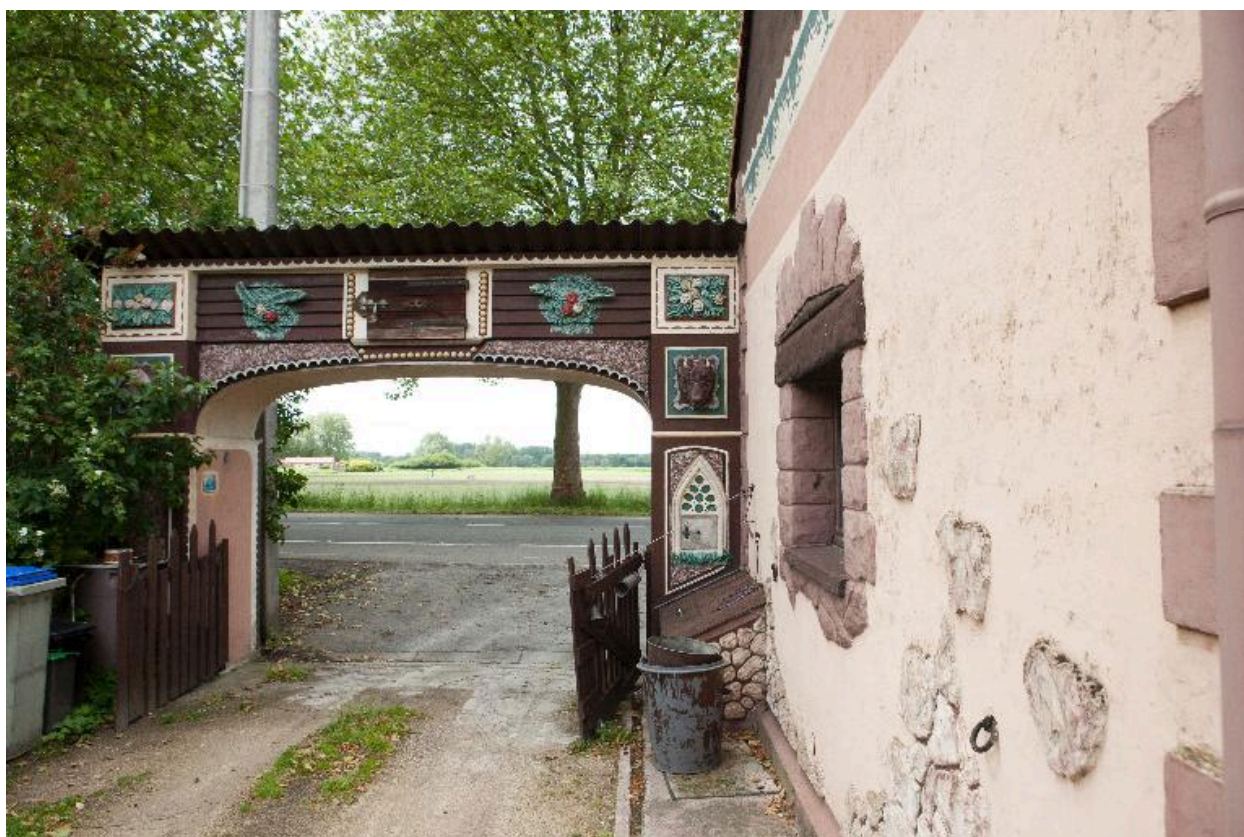
Porte cochère côté jardin, vue partielle.
