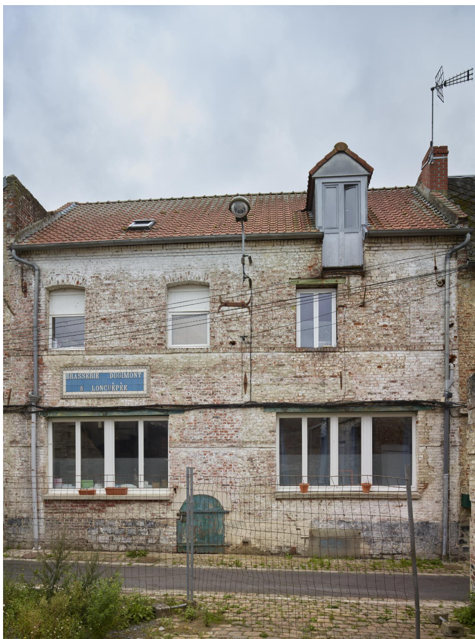
Façade de l'ancienne brasserie, vue de face.
