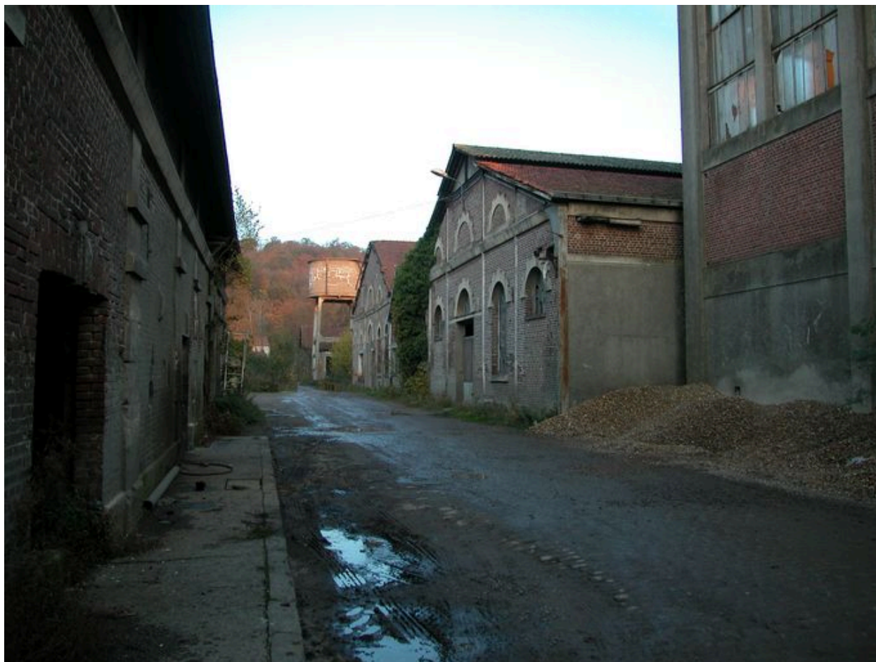
Voie de communication desservant les bâtiments industriels.
