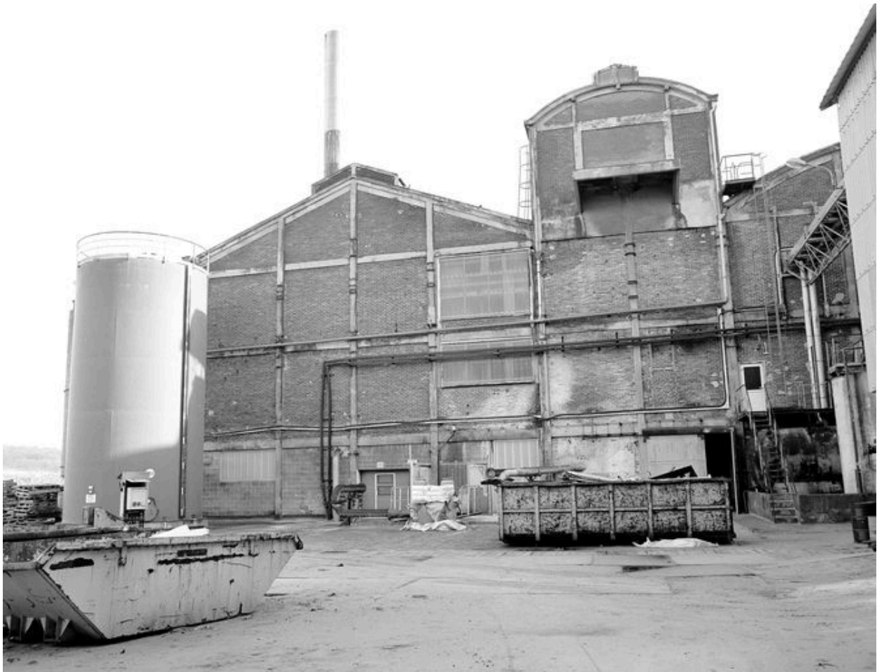
Ateliers de fabrication et chaufferie : flanc ouest.
