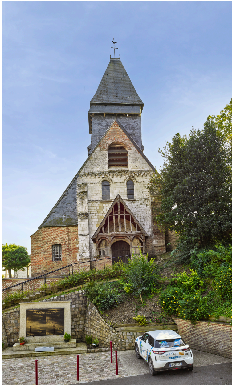
Vue de l'élévation nord de l'église.
