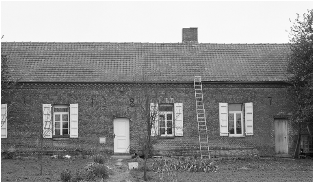
Façade postérieure du logis, avec date en fers d'ancrage : 1877.
