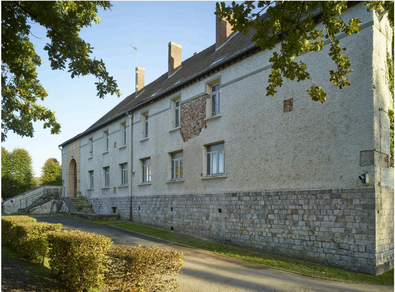
Caserne Cernay : façade avant de l'aile est. Vue orientée est-ouest. Le détail de l'appareil picard des briques est visible dans les manques de l'enduit.
