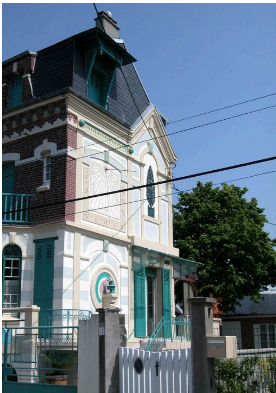
Vue rapprochée de la façade latérale droite.
