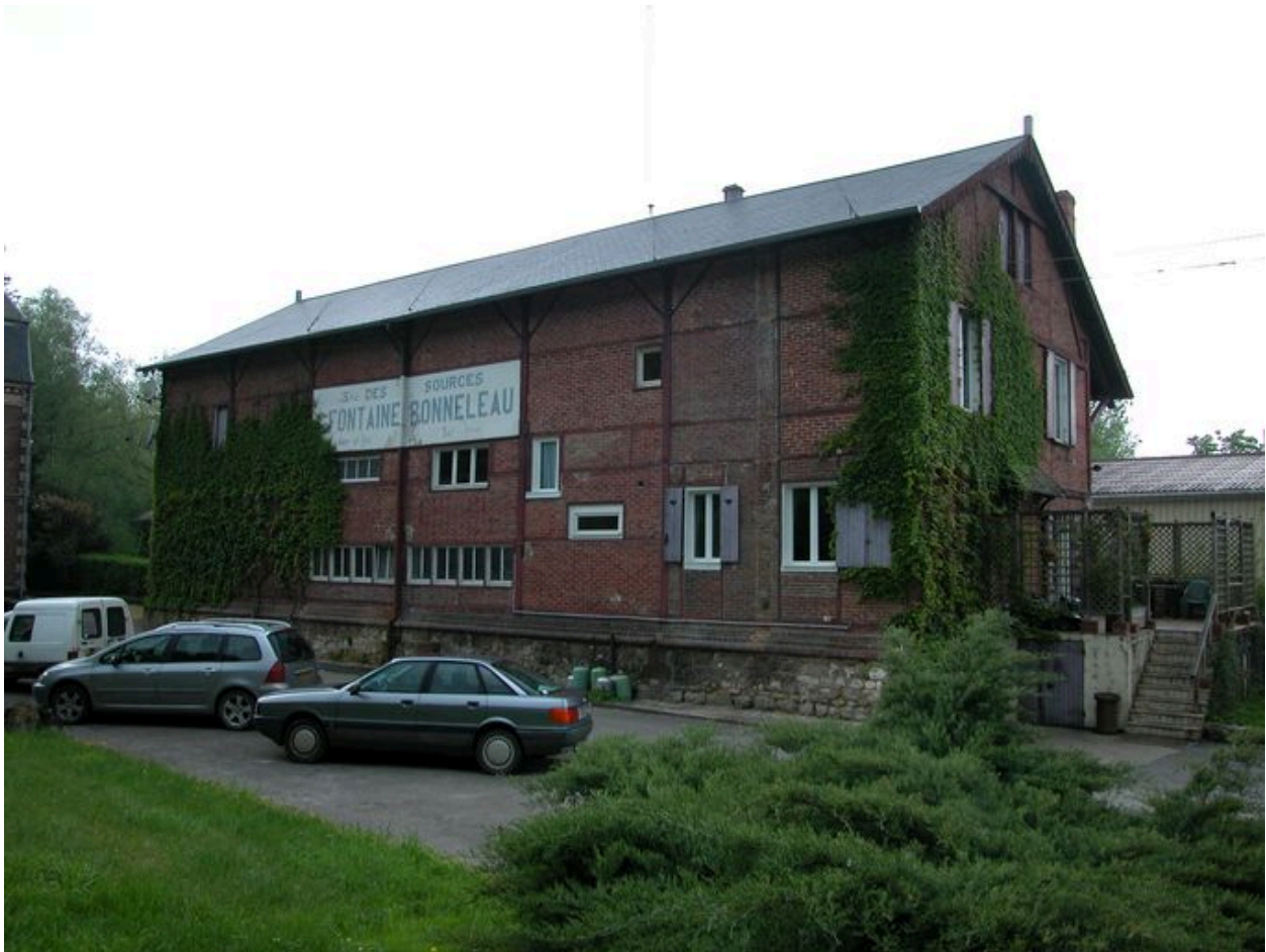
Vue d'ensemble de l'atelier de conditionnement.
