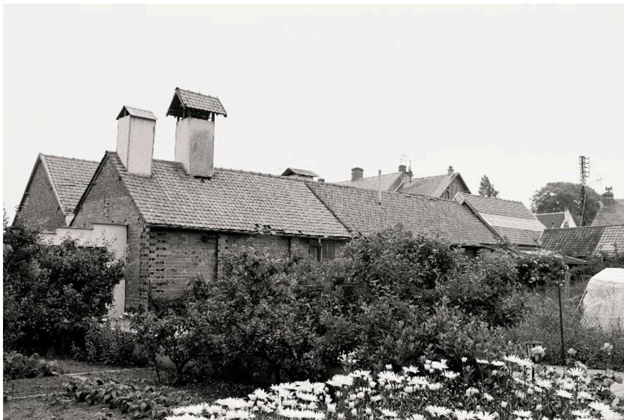
Vue des ateliers de l'ancienne fonderie Gagny et Fils.
