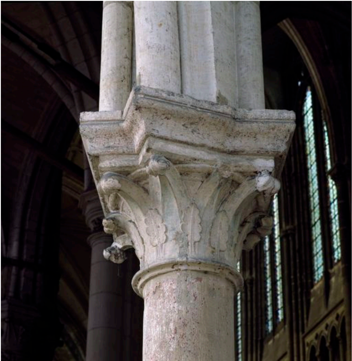
Vue d'un chapiteau de l'entrée d'une des chapelles absidiales.
