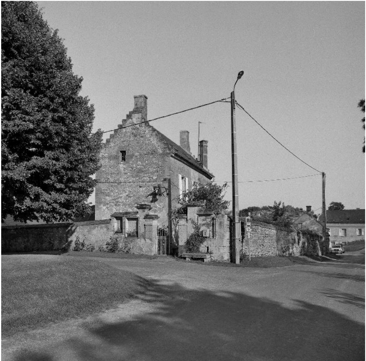
Vue générale de l'ancienne mairie-école, depuis le nord-ouest.
