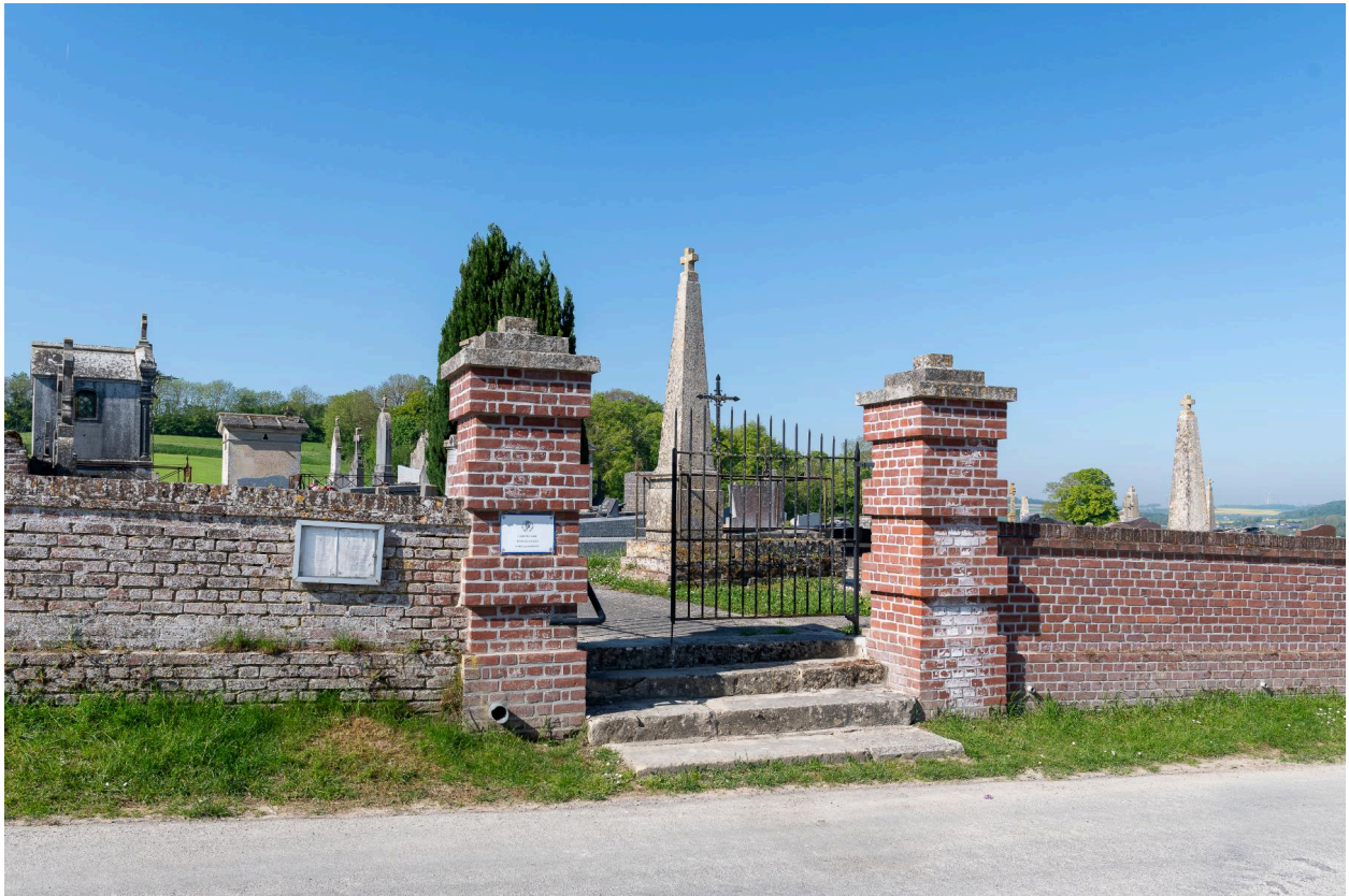
Vue générale de l'entrée du cimetière.
