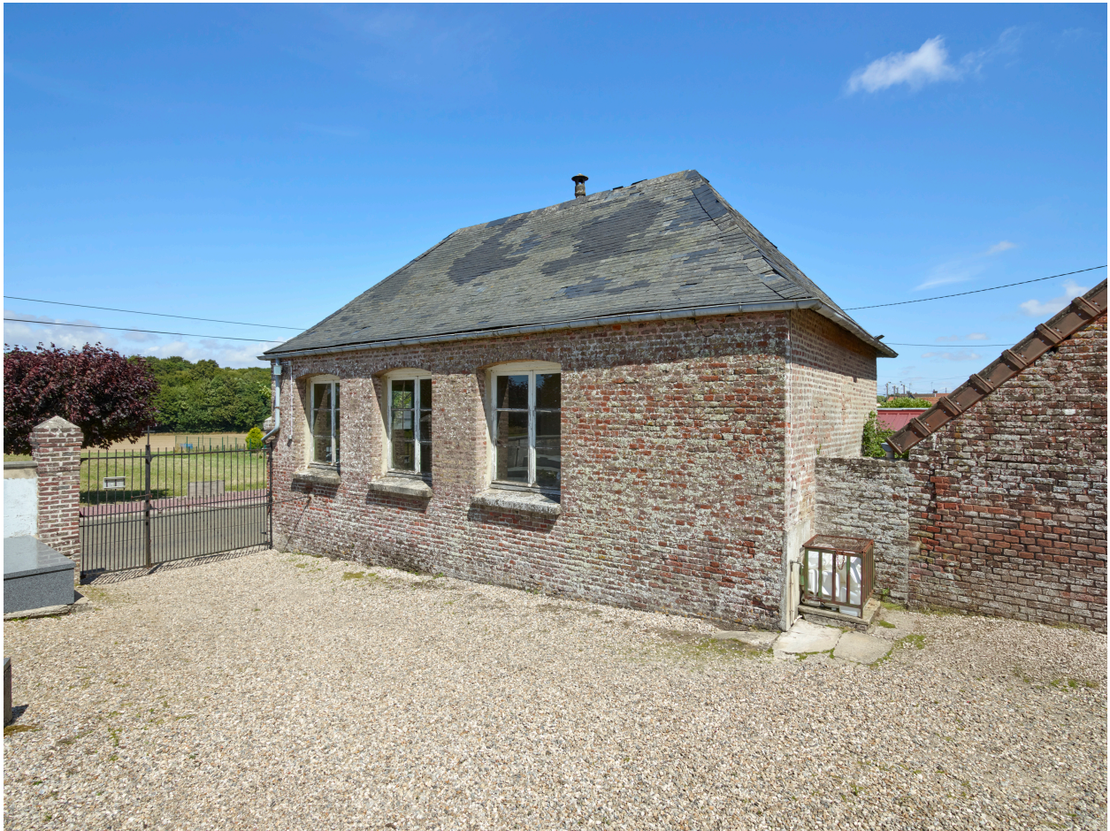
Vue ouest de l'ancienne école, depuis le cimetière.
