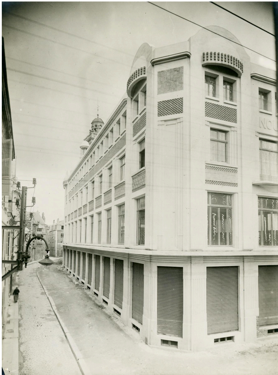
Façade rue Saint-Jacques des Nouvelles Galeries, vers 1926 (Cité de l'Architecture et du Patrimoine ; fonds des Bétons armés Hennebique ; 3-D-368).
