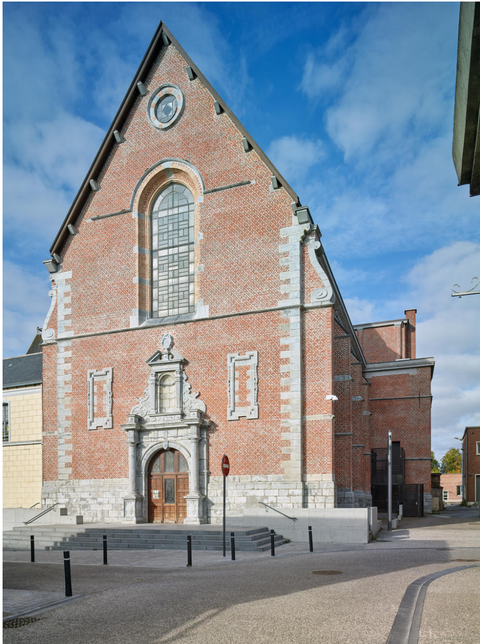
Vue de l'élévation antérieure.
