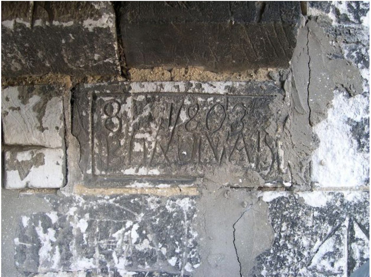
Mur nord du bas-côté nord : Graffiti.
