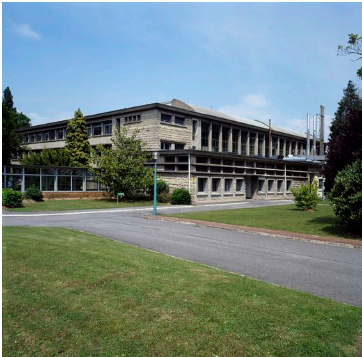
Bâtiment dit demi-grand (laboratoire et ateliers).
