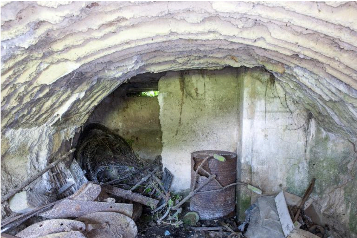
Casemate à munitions, vue intérieure
