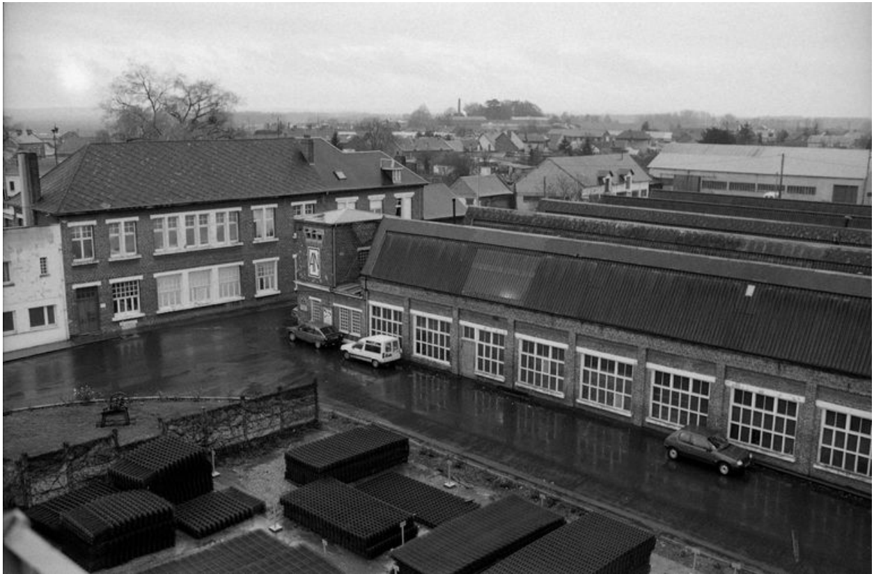
Atelier de fabrication et bureau : flanc nord-est.
