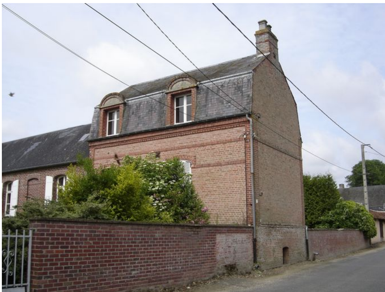
Vue principale du logis.
