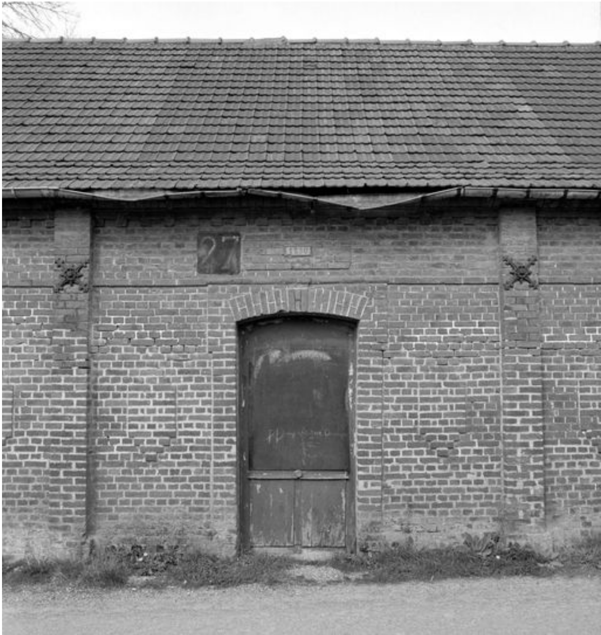
Cantine, vue de détail.
