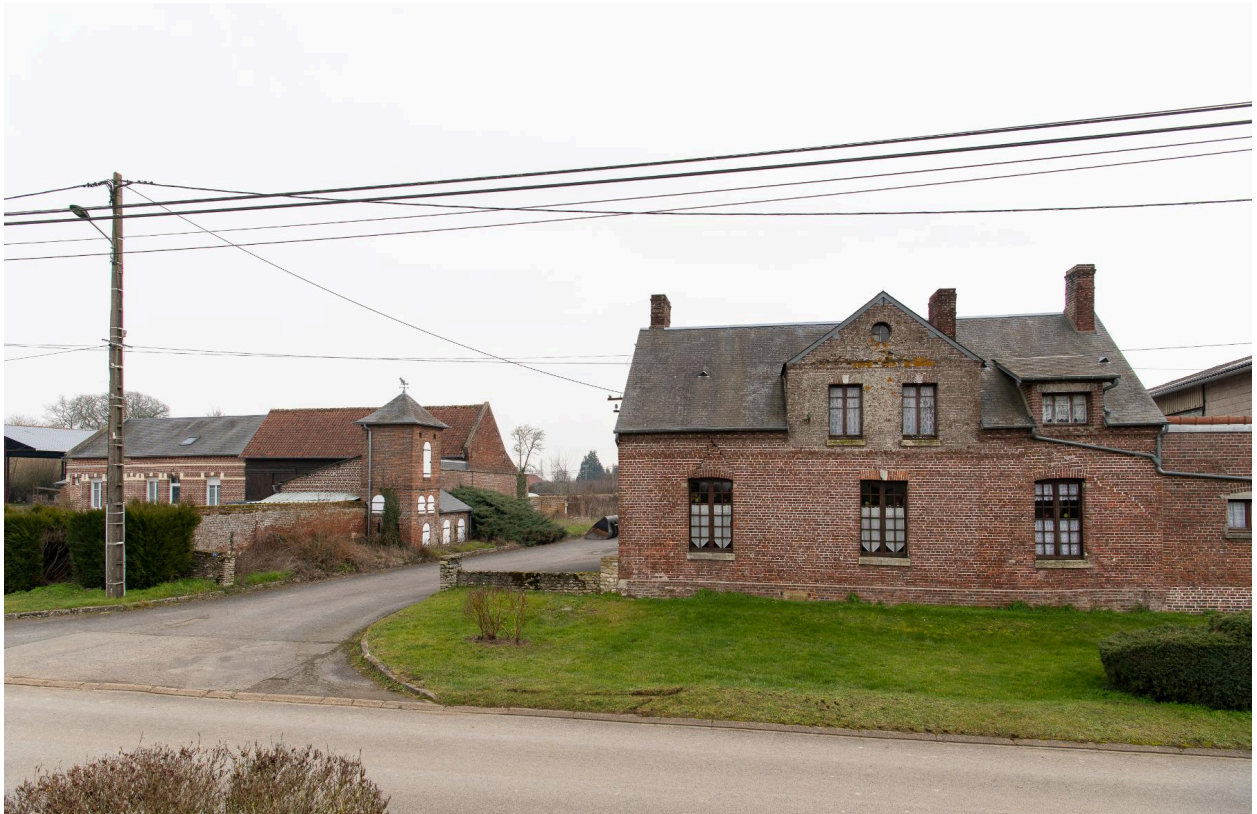
Ferme à cour de la famille Matrot, n°331 rue des Marronniers, vue depuis le nord.
