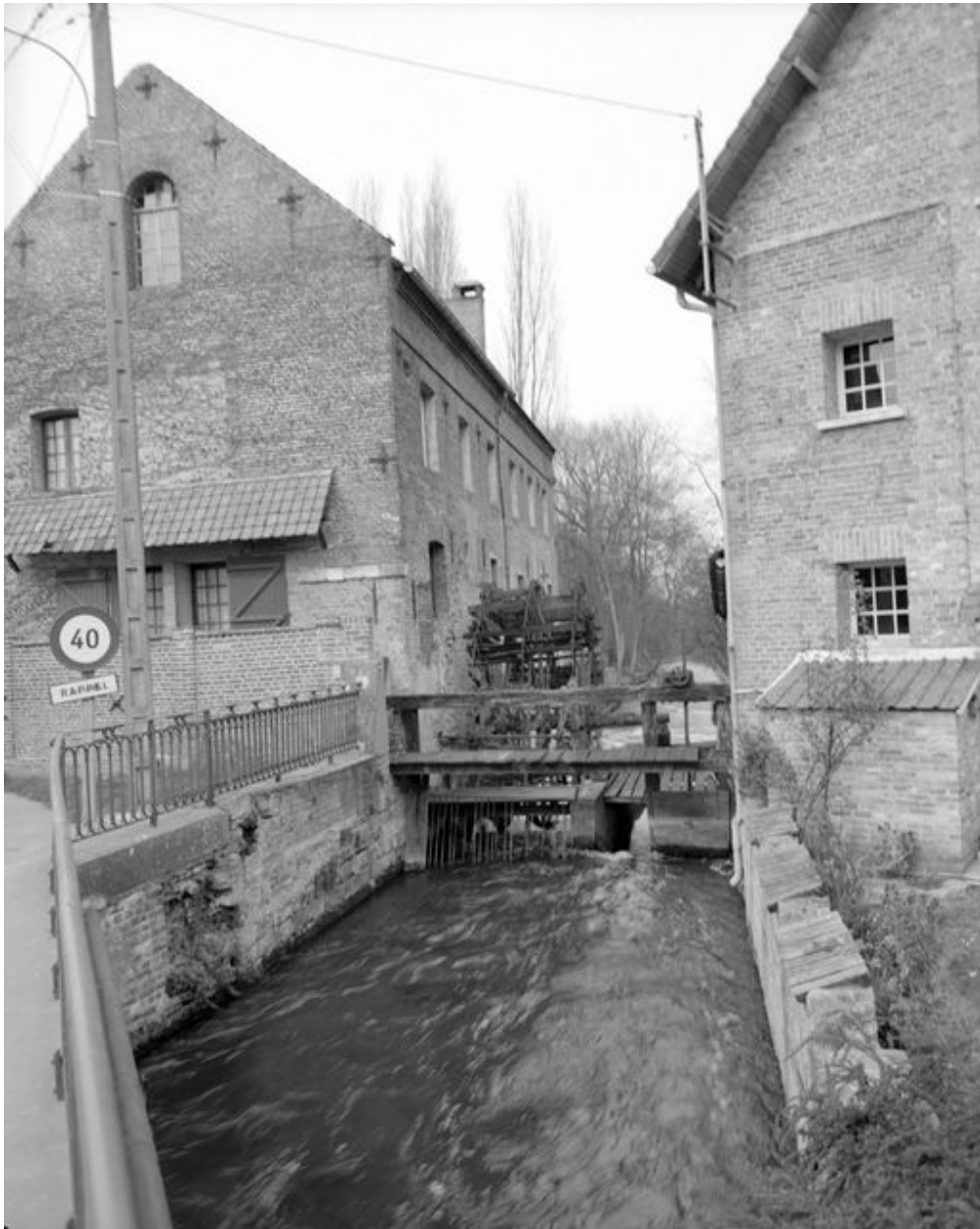
Atelier de fabrication, roue hydraulique verticale, vanne.
