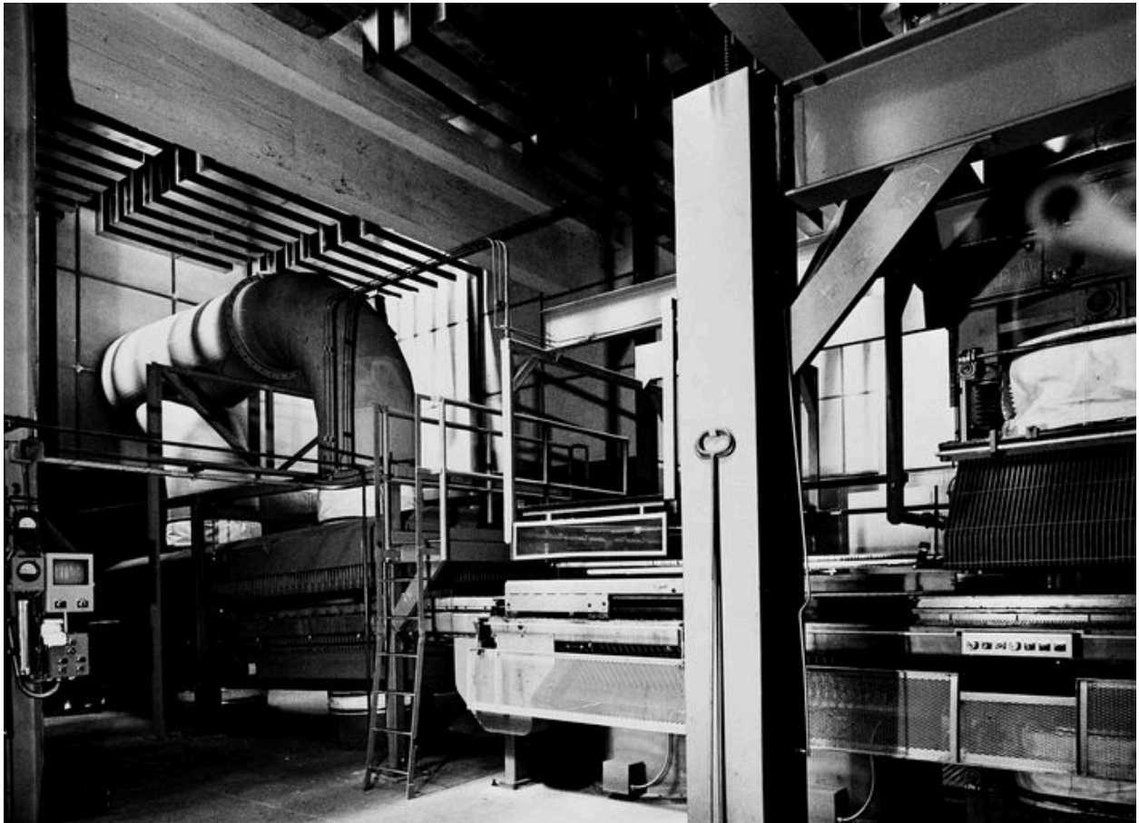
Atelier de fabrication : vue intérieure, vers 1925 (AP).
