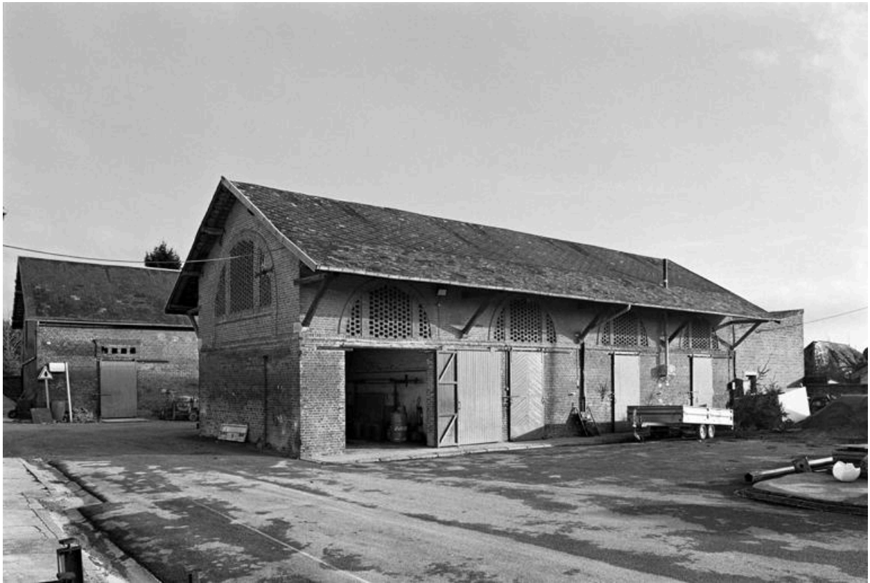
Vue d'un bâtiment de l'abattoir élevé par Gustave-Eugène Dupont entre 1898 et 1901.
