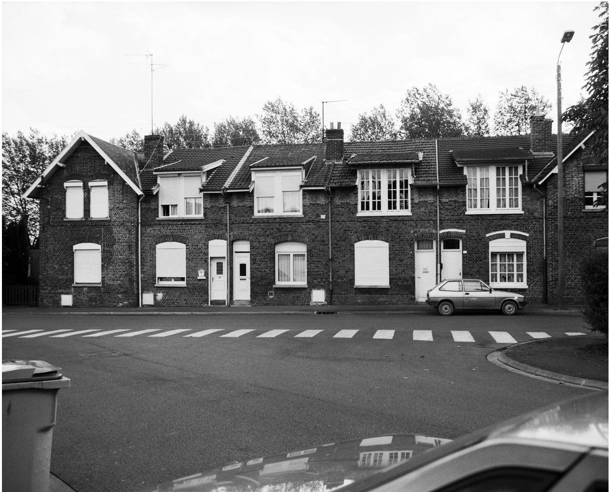
Vue générale d'un module de six maisons, numéros 6-12 de la rue Gambetta.
