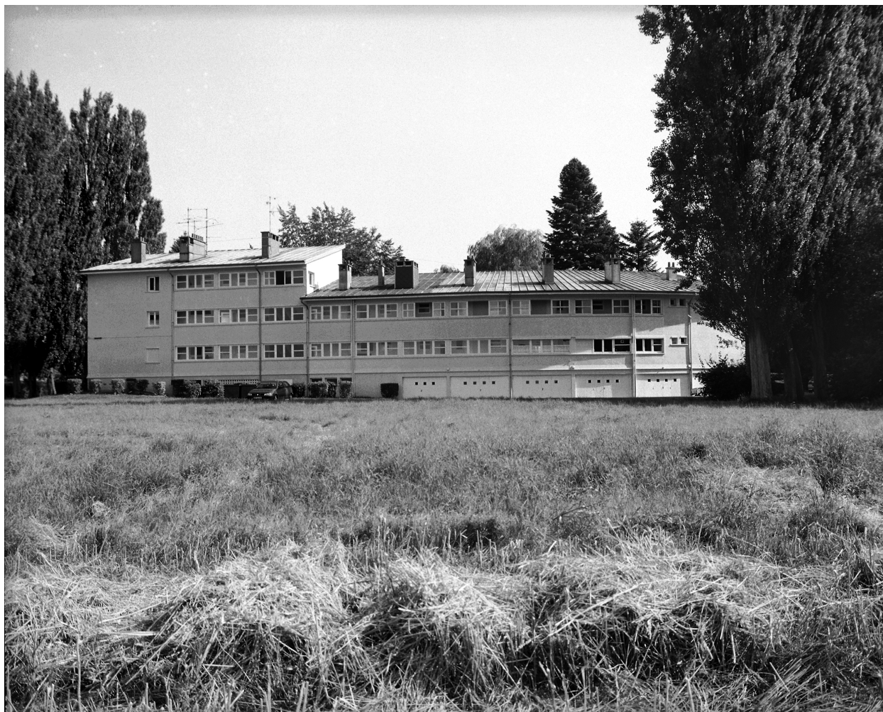
Élévation postérieure (nord) de l'immeuble incurvé.
